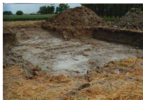
Figure 9 : Scrapage de la couche superficielle
