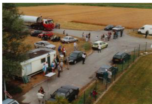
Figure 8 : Vue d'un chantier
